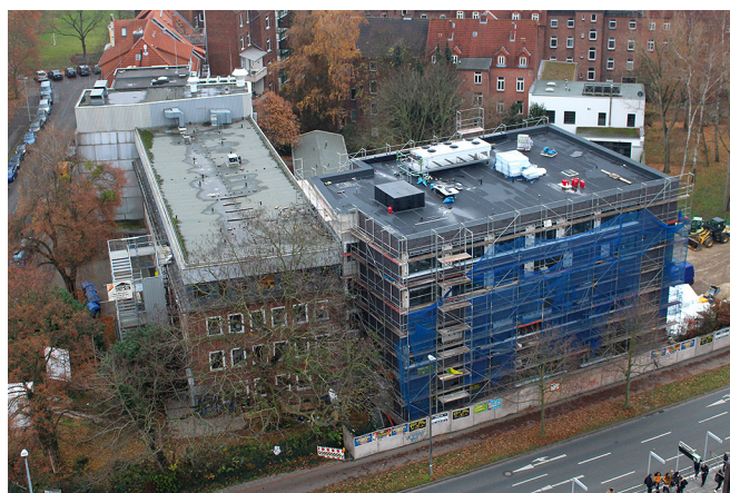
Stand der Baumaßnahme am 26.11.2018
