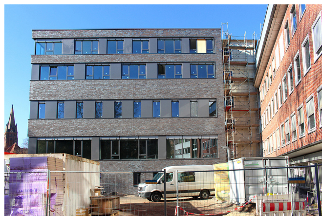
Stand der Baumaßnahme am 18.02.2019.
