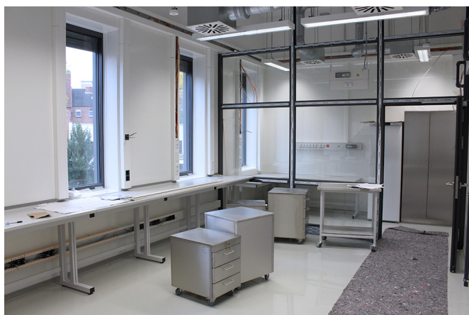
Stand der Arbeiten im neuen Hochsicherheitslabor am 17.10.2019.
